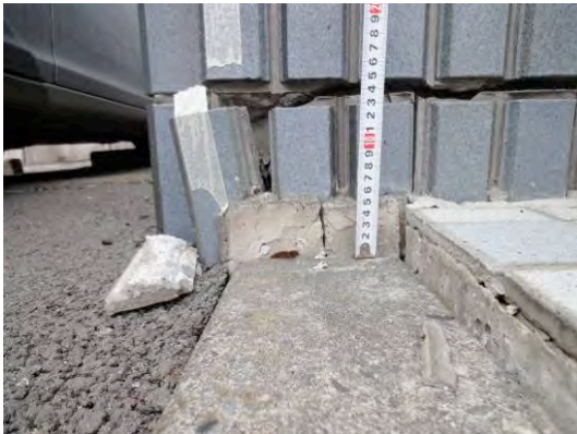
c: 50mm の沈下
