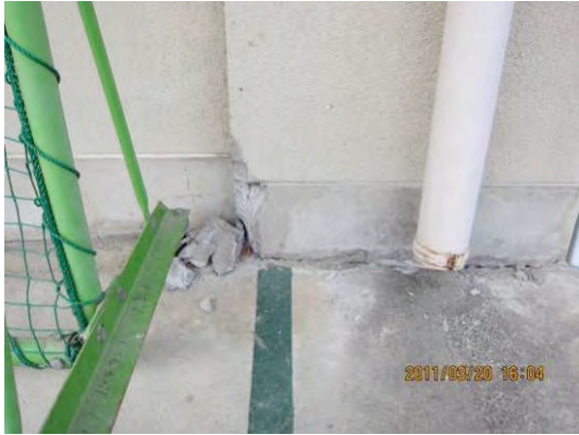
図 A:柱脚部コンクリートの剥落
