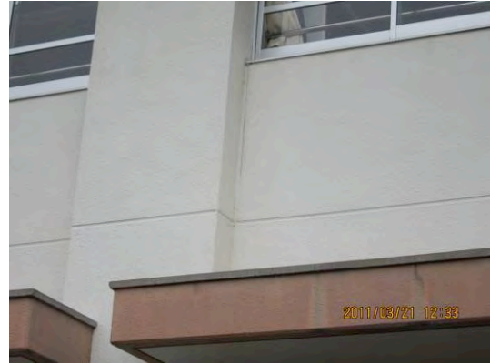
図 D:梁端部曲げひび割れ, 柱脚部の曲げひび割れ
