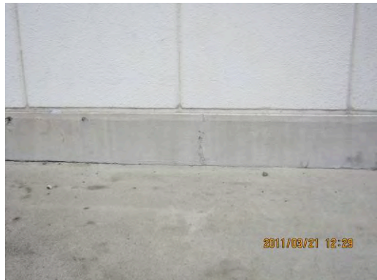
図 C: 地盤変状に伴うひび割れ
