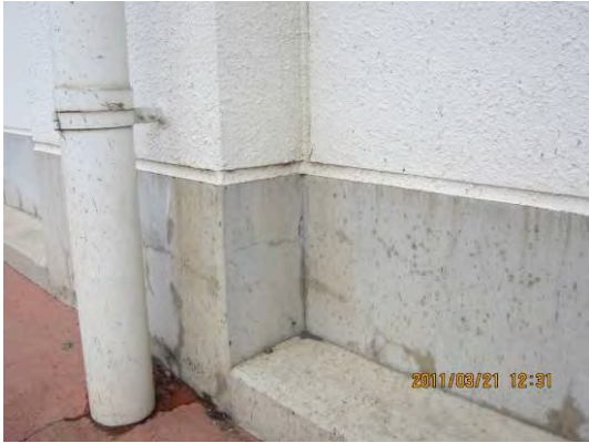
図 D:梁端部曲げひび割れ, 柱脚部の曲げひび割れ
