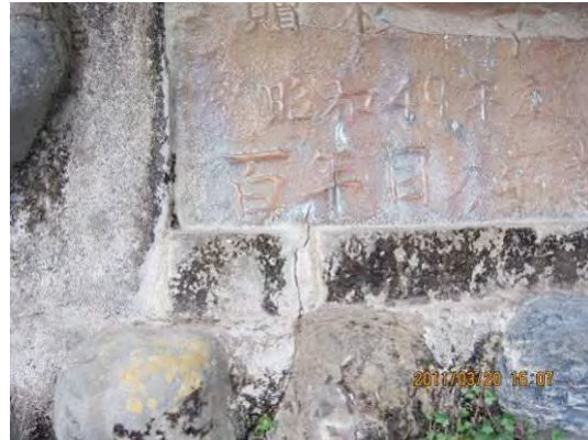
図 B:擁壁のひび割れ
