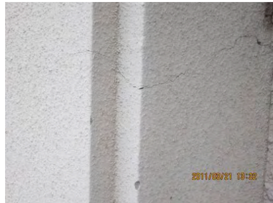
図 B:柱の曲げひび割れ
