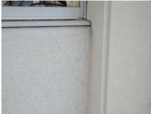
図 A:腰壁の斜めひび割れ
