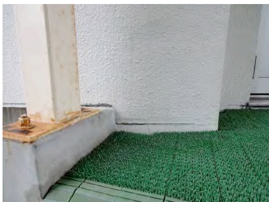
図 G:渡り廊下接合部の亀裂
