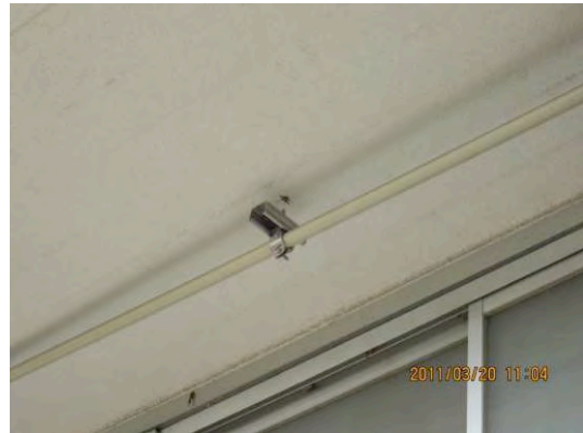
図 A:アンカーの抜け出し
