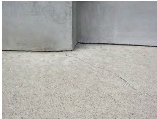
図 C:地盤の沈下
