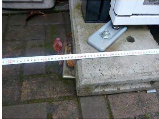
図 飲み物自動販売機の基礎部の水平移動
