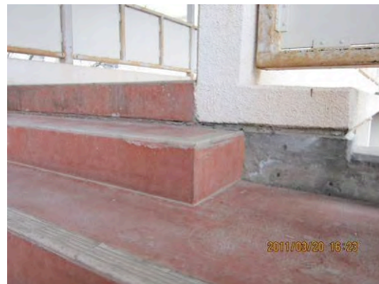
図 F:渡り廊下接合部のズレ変形
