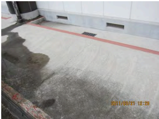
図 C: 地盤変状に伴うひび割れ
