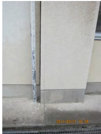
図 B: 耐力壁のせん断ひび割れと側柱の縦ひび割れ
