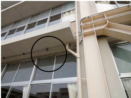
図 A:アンカーの抜け出し
