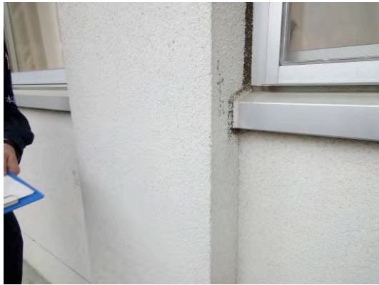
図 B:柱の曲げひび割れ
