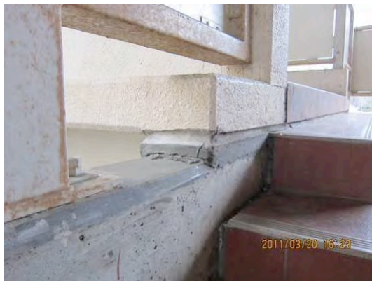
図 F:渡り廊下接合部のズレ変形
