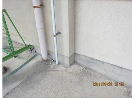
図 A:柱脚部コンクリートの剥落
