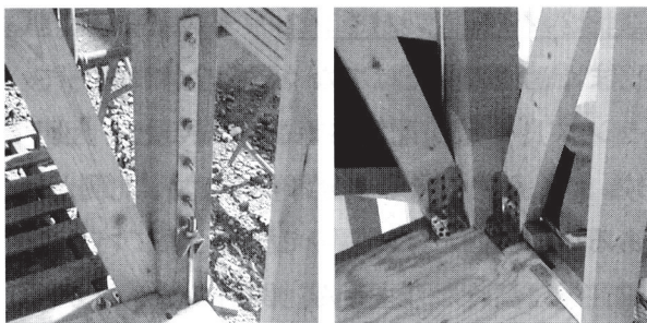
写真3. ホールダウン金物(左)と筋かい端部の金物(右)
