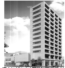
流山セントラルパーク駅前計画(施工中)
