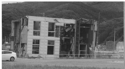
津波で転倒した建物 (2013.9撮影)
