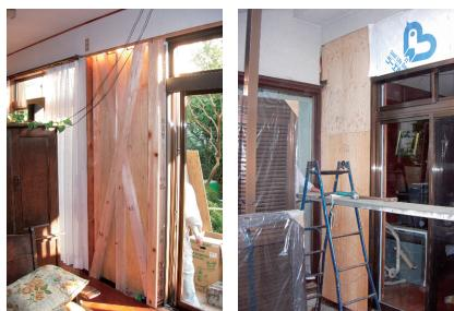
壁を強くすると、次にはその壁がつながっているコンクリートの基礎や、2階の床を補強しなければならない場合もあります。基礎や床の補強はかなり手間がかかり、工事費もかかる場合が多いので、壁以外の補強が必要かどうかは設計士さんと十分に話し合ってください。
