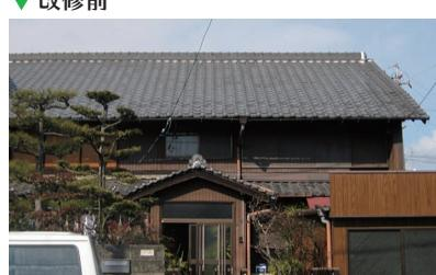
既設の日本瓦を撤去後、屋根をカラートタン葺にして軽量化
