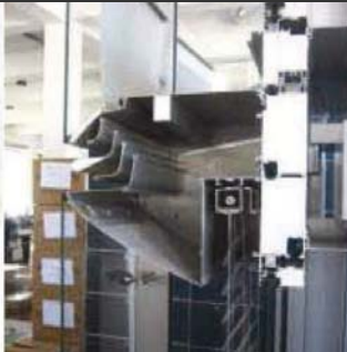
ドイツのダブルスキン事例(外:強化ガラス、内:Low-eガラス(アルゴン封入)=水平マリオン部のエアフロー⇒ドイツ:年間の65%換気のみで可能(空調レス) vs日本は年間の25%
