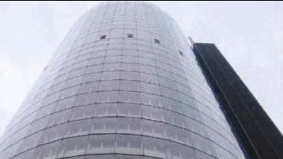
ドイツのダブルスキン事例(外:強化ガラス、内:Low-eガラス(アルゴン封入)=水平マリオン部のエアフロー⇒ドイツ:年間の65%換気のみで可能(空調レス) vs日本は年間の25%
